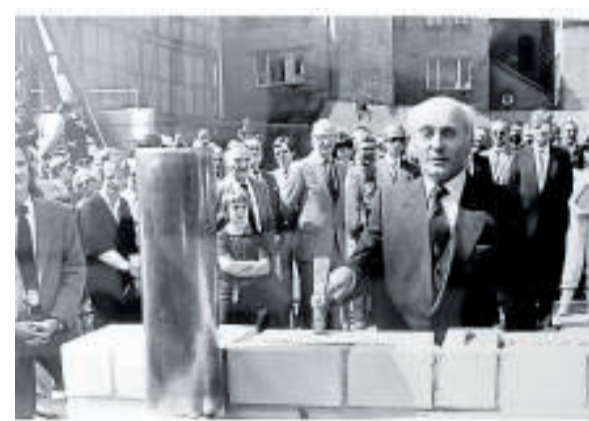
Ein Blick zurück: Am 12. Mai 1982 legte Investor Lorenz Cederbaum den Grundstein für die neue Burgpassage.
