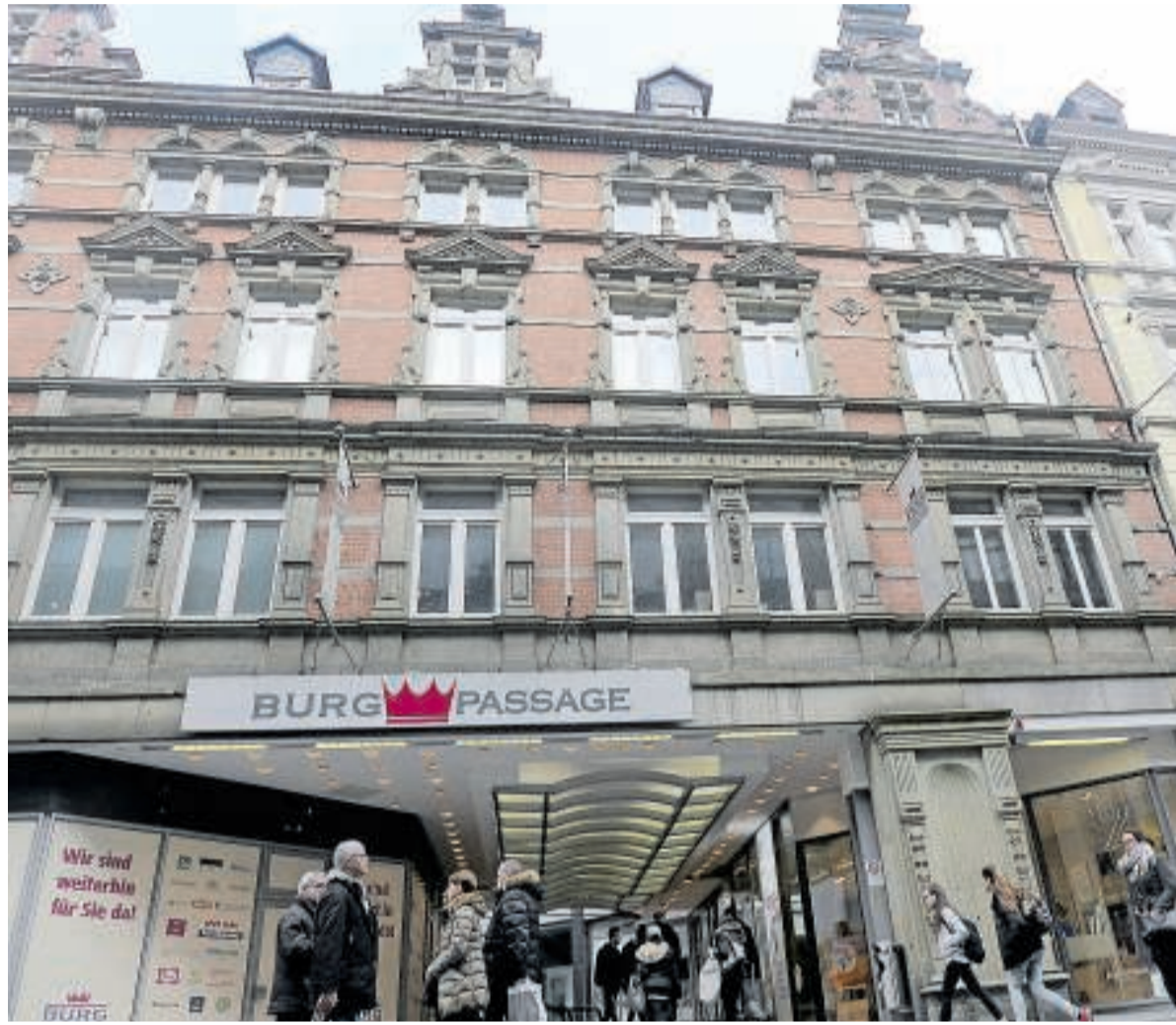
1887 entstand diese prächtige von Architekt F. Röper gestaltete Fassade am Hutfiltern 8. Sie steht heute unter Denkmalschutz. Für die neue „Burggasse“ müsste ein weiteres Stück der Fassade weichen. Fotos: Norbert Jonscher
